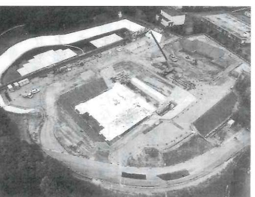
（1）凝集沈殿処理施設（着水井、粉削、原水調整池の盛土、余剰土の場外搬出等の造成工事）
